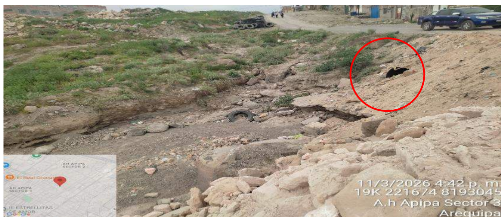
IMAGEN 03: SE OBSERVA LA LA QUEBRADA S/N QUE SOLO PRESENTA UNA ALCANTARILLA COMO SE MUESTRA EN EL CIRCULO Y SE ENCUENTRA TAPADA CON MATERIAL PROPIO CREANDOSE UNA VIA VEHICULAR
