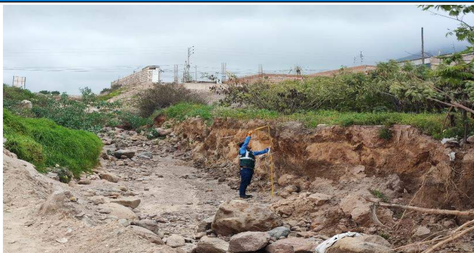
IMAGEN 01: SE OBSERVA LA COLMATACION DEL CAUCE DE LA QUEBRADA S/N EN EL SECTOR 2 DE APIPA ESTAPA EROSIONADA PARA DESCOLMATACION Y CONSTRUCCION DE MURO DE CONTENCIÓN
