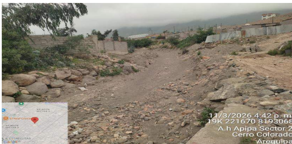
IMAGEN 02: SE OBSERVA LAS MARGENES SIN PROTECCION EN LA QUEBRADA S/N ANTE UNA MAXIMA AVENIDA LA POBLACION SE ENCUENTRAN EN PELIGRO A INUNDACION
